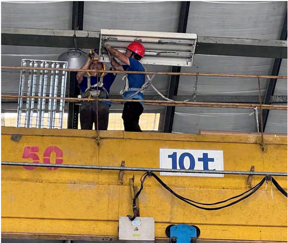
广日电梯为车间更换节能照明设施
